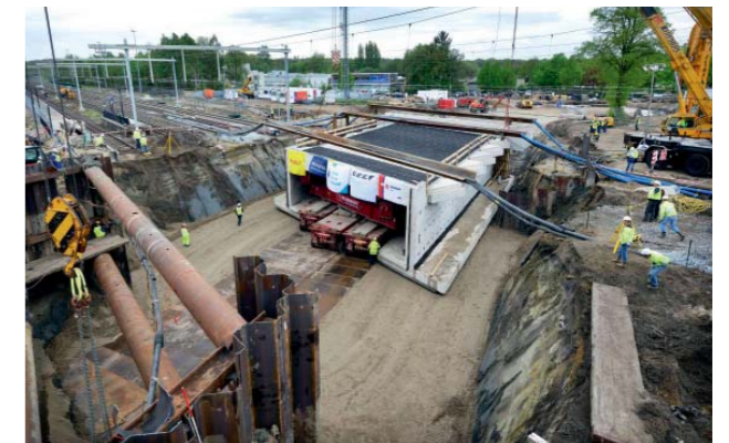
Op 7 mei 2013 werd de onderdoorgang onder het spoor geschoven in het EFRO-project De Groene Loper in Oldenzaal.
